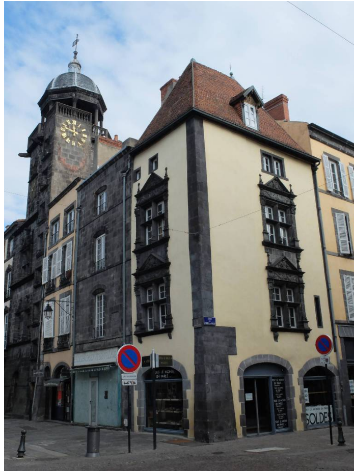
Maison Soubrany (avant), 41 rue de l'Hôtel-de-Ville, Riom
